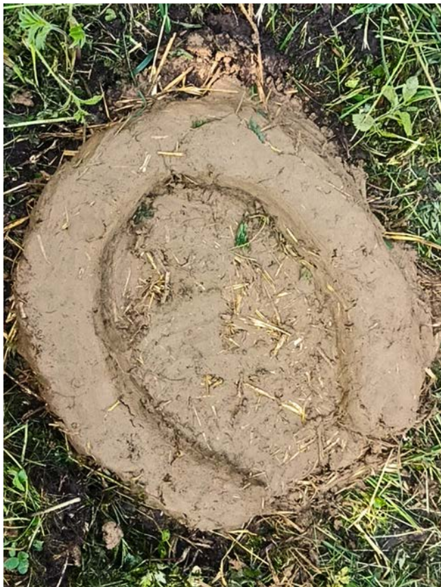
Рис. 5. Формування підковоподібного борта на основі печі
