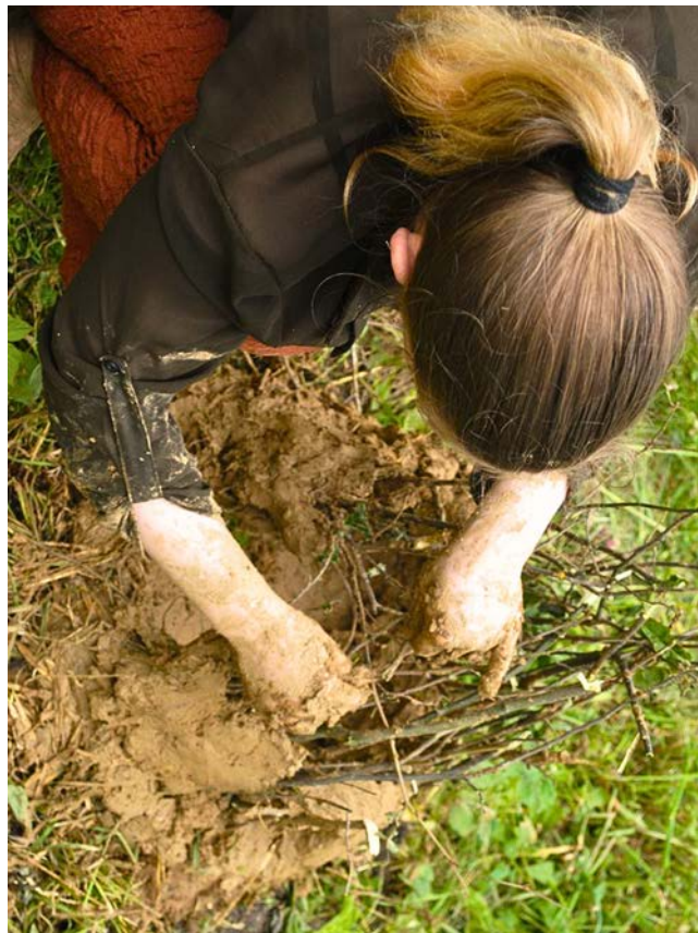
Рис. 6. Накладання формувальної маси на прутяний каркас печі
