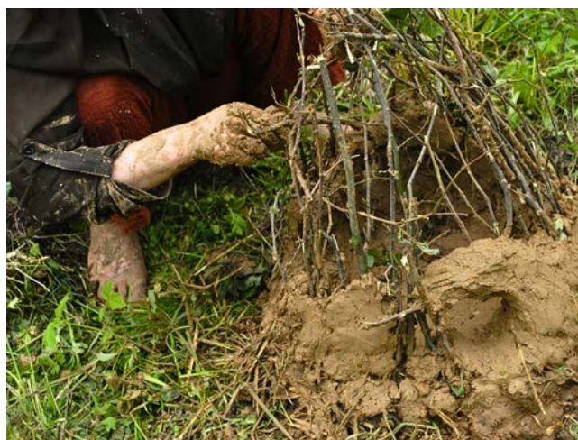
Рис. 8. Накладання формувальної маси на прутяний каркас печі
