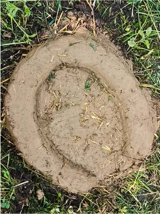
Рис. 5. Формування підковоподібного борта на основі печі
