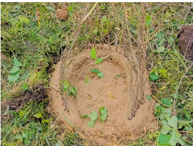
Рис. 7. Етап встромлення прутів у підковоподібний борт глиняної печі
