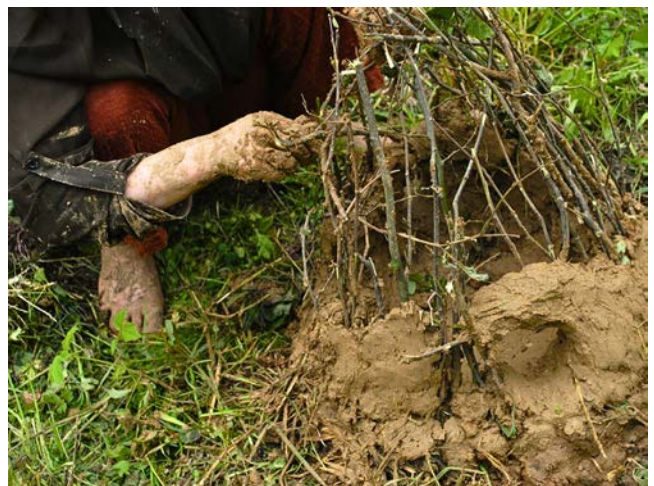
Рис. 8. Накладання формувальної маси на прутяний каркас печі
