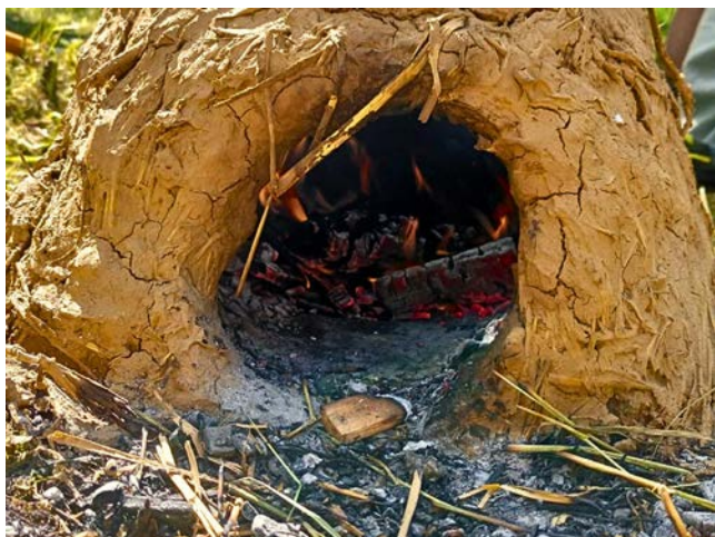
Рис. 11. Отвір печі під час обпалу одразу після зведення
